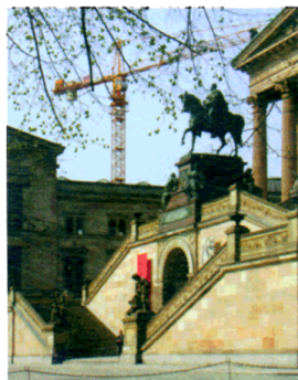
Ein einziges Management-system für die Gebäude- und Sicherheitstechnik bezieht auf der Berliner Museumsinsel – hier der Eingang zur Alten Nationalgalerie – sieben Gebäude mit ein.
